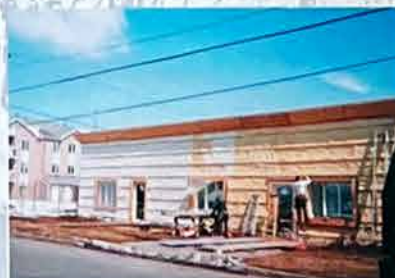
| Isolation des murs
