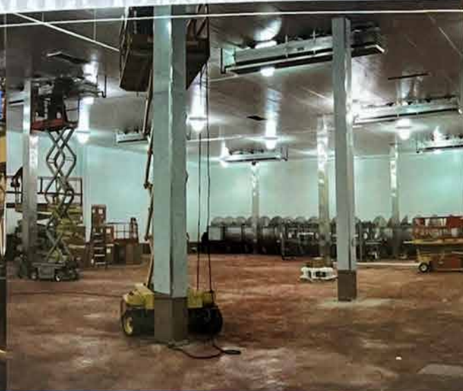
Finition d'une salle de production
