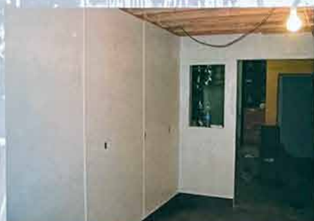
| Installation de fibre de verre
