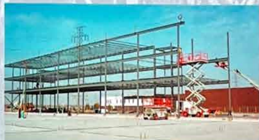
Montage d'une structure d'acier
