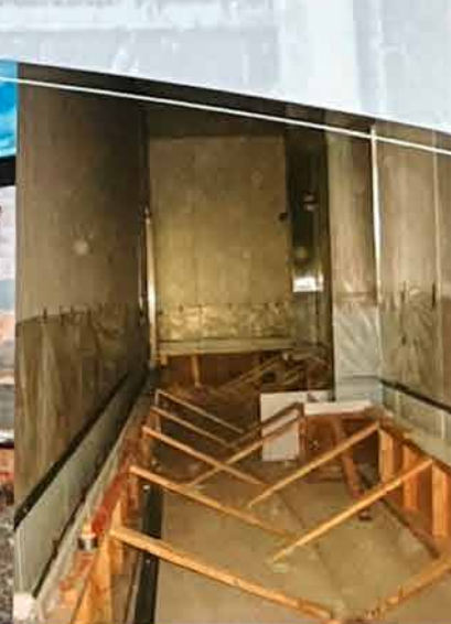
Construction de murets de béton
