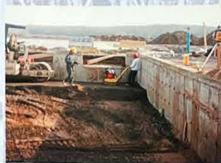
Remblai et compaction
