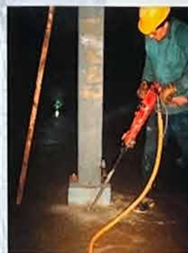
Cassage de béton
