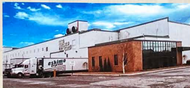
Centre frigorifique Montérégie Entrepôt frigorifique, 200 000 pi 2
