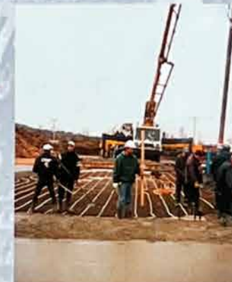
Finition de béton
