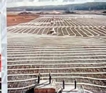
Chauffage de plancher
