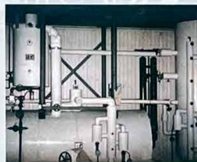
| Isolation de tuyauterie de réfrigération
